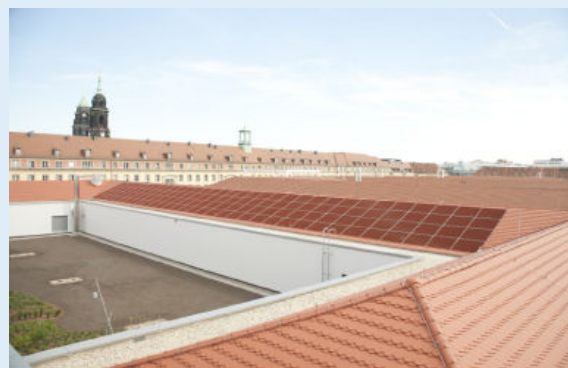
Dachansicht nach Einbau des Sichtschutzes
