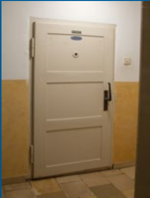
▲ Hinter dieser Kühlraumtür mit einer Isolierung aus Kork befindet sich ein voll funktionsfähiges „Denkmal der Güntner Industrie-Kultur“ – ein stiller Güntner Luftkühler der ersten Generation.
