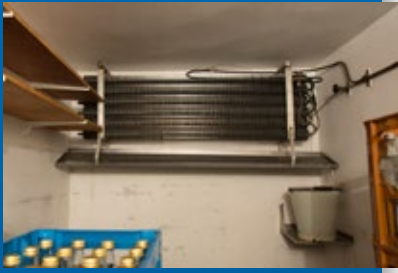
▲ Seit rund 65 Jahren kühlt der stille Kühler den Kühlraum störungsfrei auf etwa 8 bis 10 °C.
