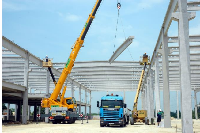
Bild aus der Bauphase der Erweiterung in Tata, Ungarn
