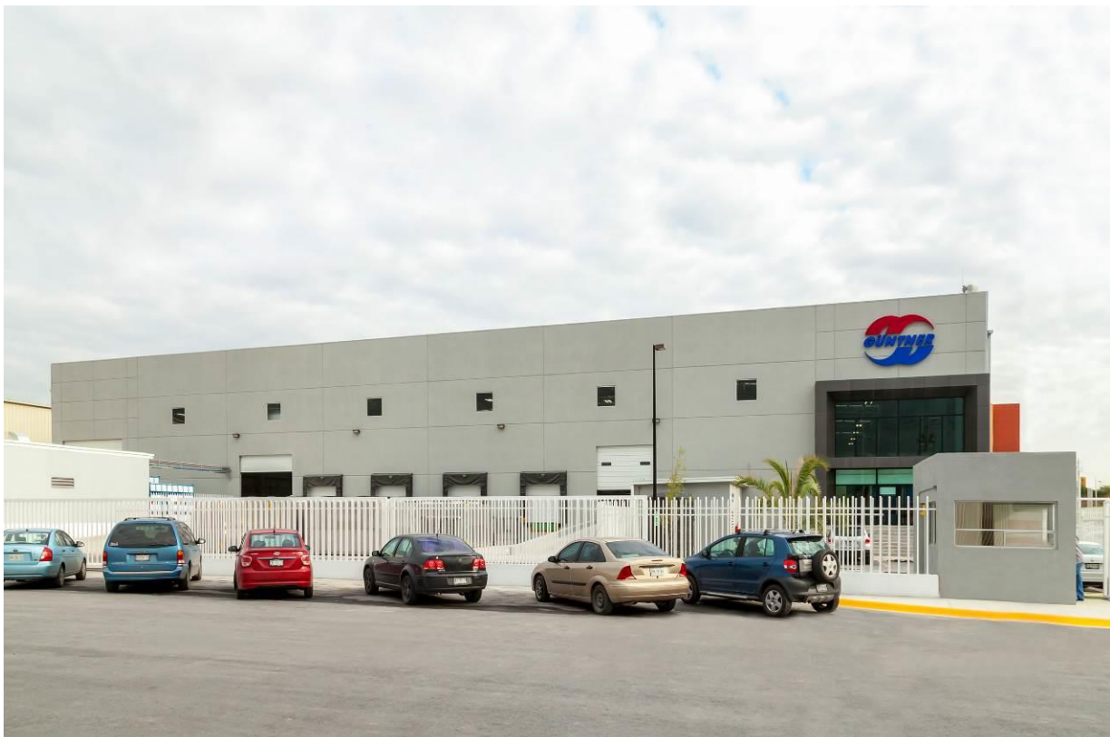
Die neue Halle 3
