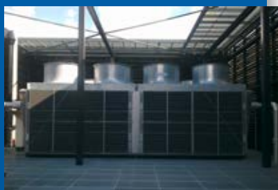
▲ Herzstück des Konzepts: die Hybriden Trockenkühler von JAEGLI Hybridtechnologie AG
