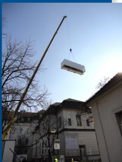
Ein Kran hievt die Rückkühler auf das Dach der Intensivstation IPS1.
