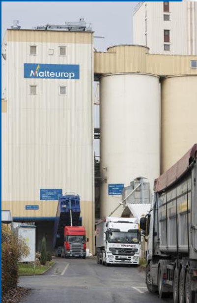
Der europäische Malzhersteller Malteurop nutzt in seiner Kälteanlage sowohl Güntner Luftherhitzeblöcke als auch thermowave Plattenwärmeübertrager.
