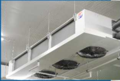
Güntner Luftkühler Vario DUAL (Typ DHN) verteilen die kalte Luft gleichmäßig im Raum.
