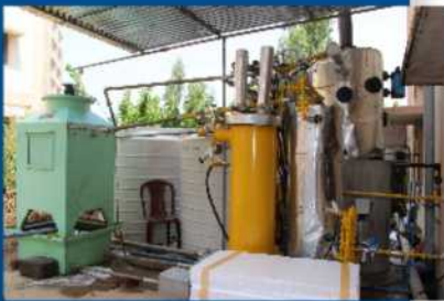
Die Kleinkühlanlage GreenCHILL der indischen Firma New Leaf Dynamic nutzt unter anderem den in Indien reichlich vorhandenen Büffel- und Rinderdung bzw. andere land- und forstwirtschaftliche Abfälle sowie Biogas als Primärenergieträger.
