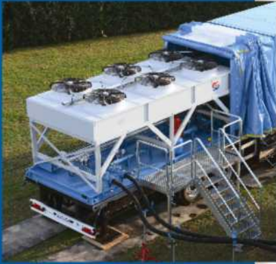
Der Güntner Vario FLAT Rückkühler S-GFH hat Sondermaße und passt genau auf den Container. Er wurde für den Transport zusätzlich versteift und auch die Kupferverrohrung ist verstärkt.
