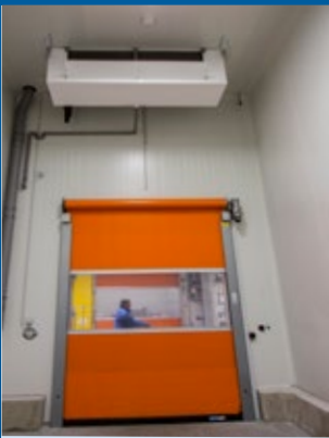
▲ Güntner Sole-Luftkühler mit aufklappbaren, Schwitzwasser-freien Wannen
