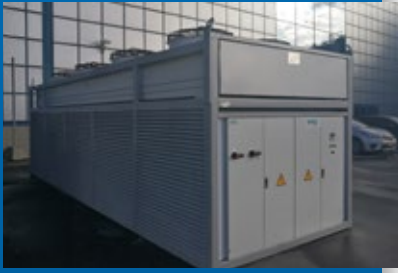
▲ Der Güntner Verflüssiger FLAT Vario, Typ GCHV, bildet mit der Container-Lösung eine bauliche Einheit, den sogenannten AIRCOOL Monoblock.
