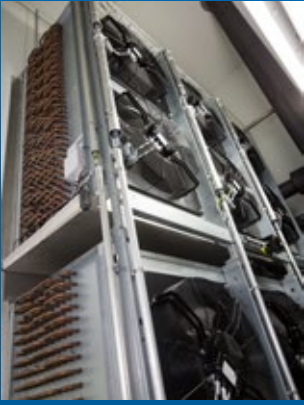
▲ Hinter der Klimakammer sind die drückenden Ventilatoren der Güntner Luftkühler Application BLAST, Typ GFN, montiert.
