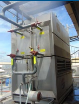
▲ Zwei Güntner ECOSS Verdunstungsverflüssiger geben die überschüssige Wärme der NH 3 -Kompressoren an die Umgebung ab.
