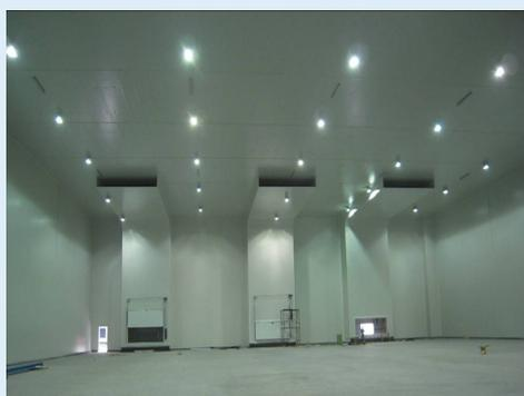
Tiefkühlager mit Schächten für eine Kühlung bei -25 °C
