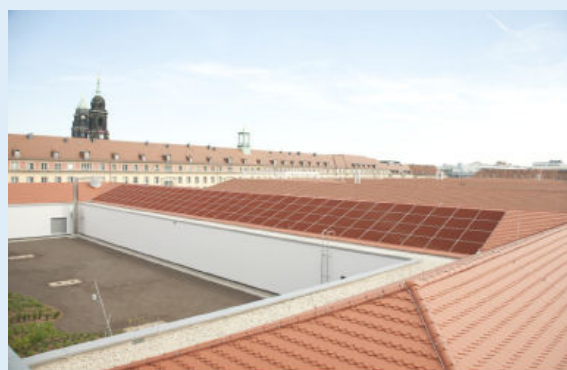
Dachansicht nach Einbau des Sichtschutzes
