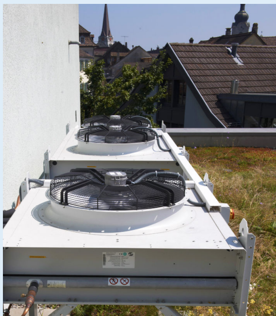
Die GVHX-Verflüssiger sind mit besonders leisen und energieeffizienten EC-Ventilatoren ausgestattet.
