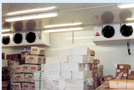
Tiefkühlager mit Luftkühler der Baureihe GHN
