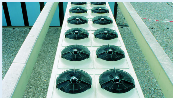
Jeder V-Block-Rückkühler von Güntner verfügt über die bewährte Güntner Tragrohrkonstruktion.
