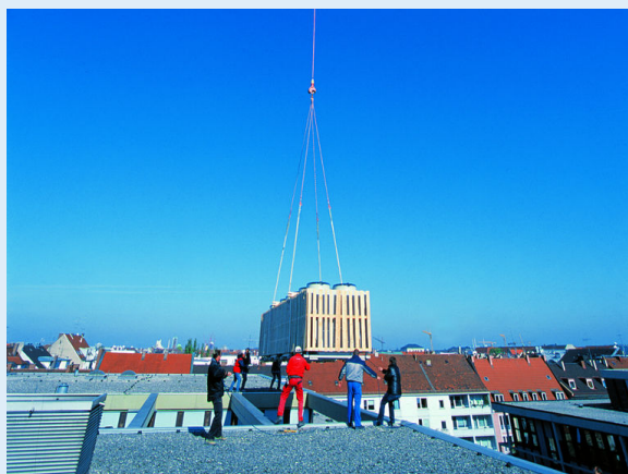
Die V-Block-Rückkühler von Güntner gelangen per Hubschrauber direkt an ihren Einsatzort auf dem Dach der Ludwig-Maximilians-Universität gegenüber der Alten Pinakothek.
