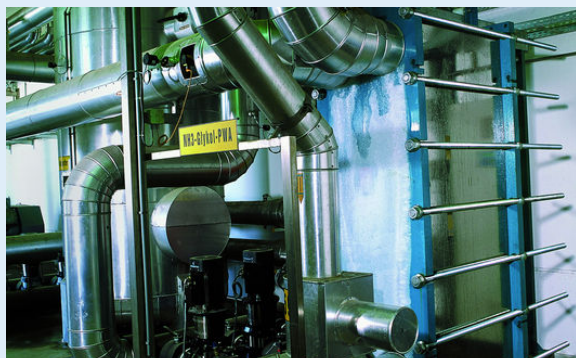
Ammoniak-Verdampfer TL 850 von thermowave
