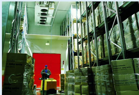
Höchste Betriebssicherheit mit den Güntner-NH 3 -Verdampfern S-ADHN 066D/412 im Tiefkühlager
