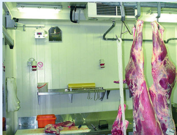
Zugluftfreie Arbeitsraumkühlung mit dem Günstner Verdampfer GDF
