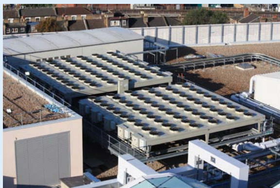
61 Güntner Rückkühler GFH sorgen für geräuscharmen Betrieb und Energieeffizienz.
