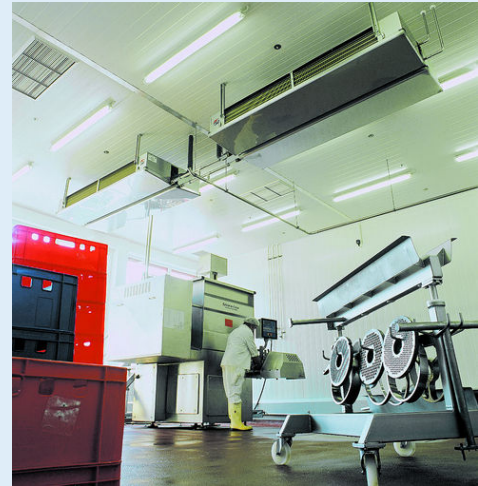
Güntner GBK als Hygieneausführung im Einsatz zur zugfreien und geräuscharmen Kühlung
