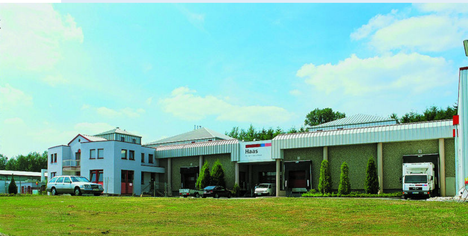
Firmensitz der Achim Haas GmbH in Nonnweiler: Aufgrund steigender Nachfrage um Einfrier- und Tiefkühlräume erweiterter Bau
